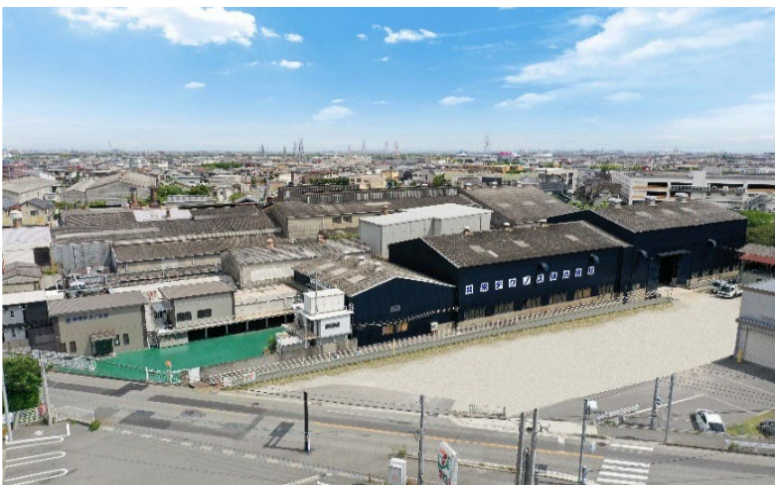
本社・第一工場
