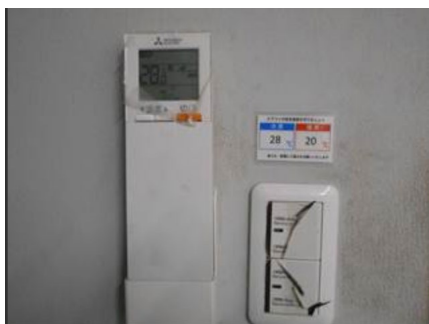
○ダンパー班建屋内建屋
