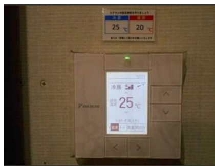
○第二工場5工区
